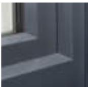
Die gestoßene Aluschale sorgt für Bewegungsfreiheit zwischen den Aluteilen der Schale. So werden thermische Unterschiede ausgeglichen. Außerdem fügen sich die
