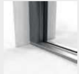
↑ Flache Schwellen- variante mit nur 2 cm Höhe (barrierefrei).
